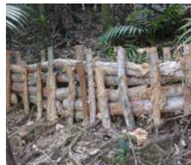
Des petits barrages végétalisés fabriqués à partir de poteaux de niaoulis ont été construits, ils doivent permettre un contrôle passif de l'érosion, une mesure de celle-ci ainsi qu'une restauration de sous-couvert forestier. (Photo association Tipwoto)
