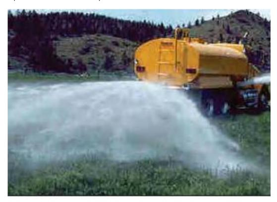
Figure 21 : Arrosage du sol visant à réduire la dispersion des fibres d'amiante sur chantier
