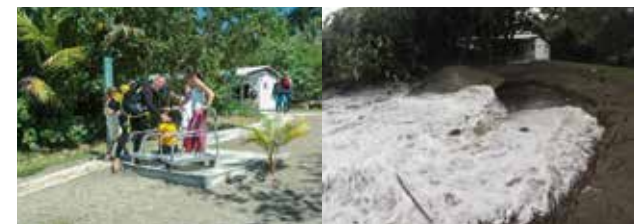
Rampe d'accès en 2007 et 2015.
