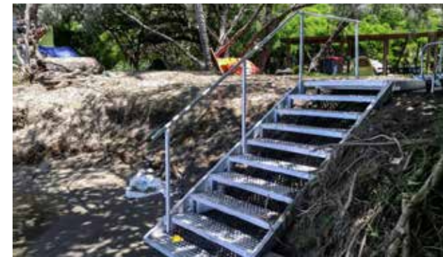
L'escalier installé en janvier 2017.
