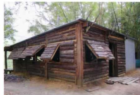
Début 2016, l'association Tipwoto a construit ce campement de chasse pour la régulation des cerfs et cochons ensauvagés.
