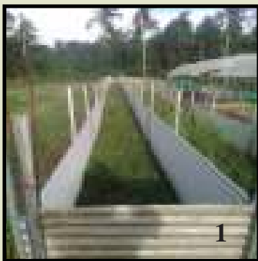
Mise en place des matériaux
