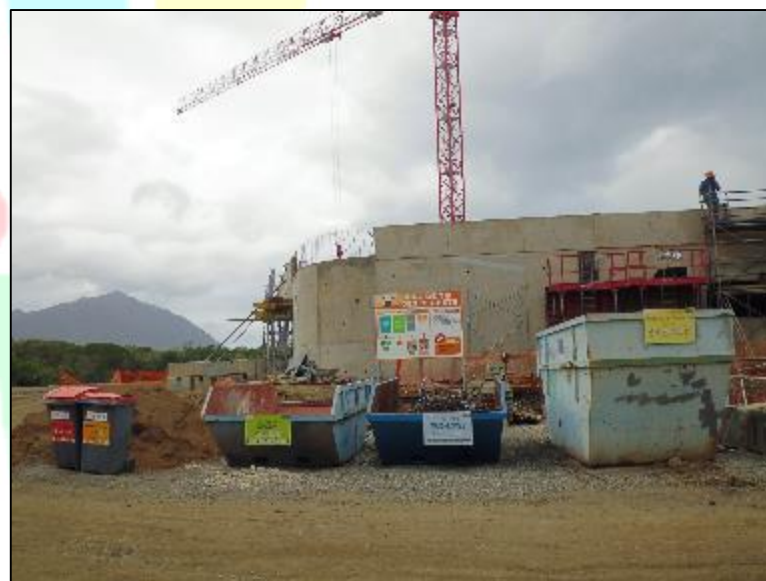
Aire de tri des déchets (5 niveaux de tri) Lycée du Mont Dore – ETAT/NC – 16/10/15
