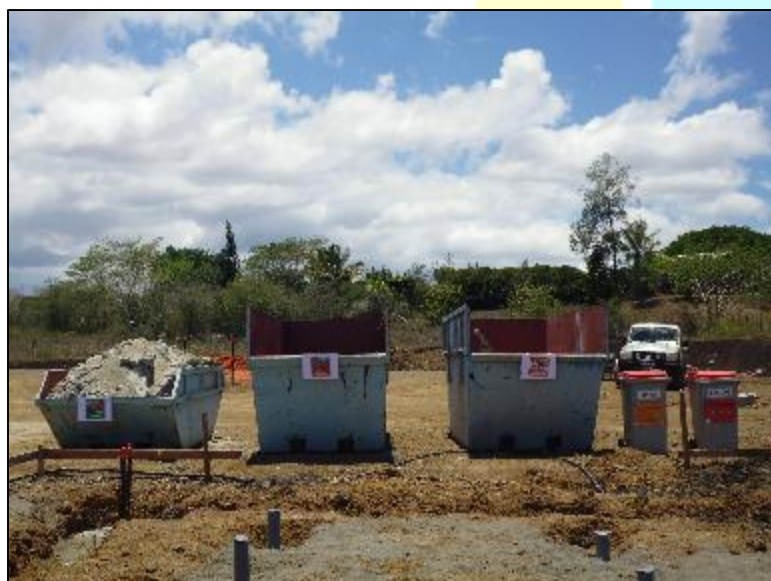
Aire de tri des déchets (5 niveaux de tri) Collège 400 – SAEML VKP – Koné - 9/06/15
